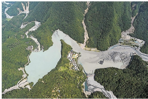
93.36%の堆砂率でダム湖がほぼ埋まった状態の雨畑ダム。左側がダムの堤体部分=8月上旬、山梨県早川町(本社ヘリ「ジェリコ1号」から)
