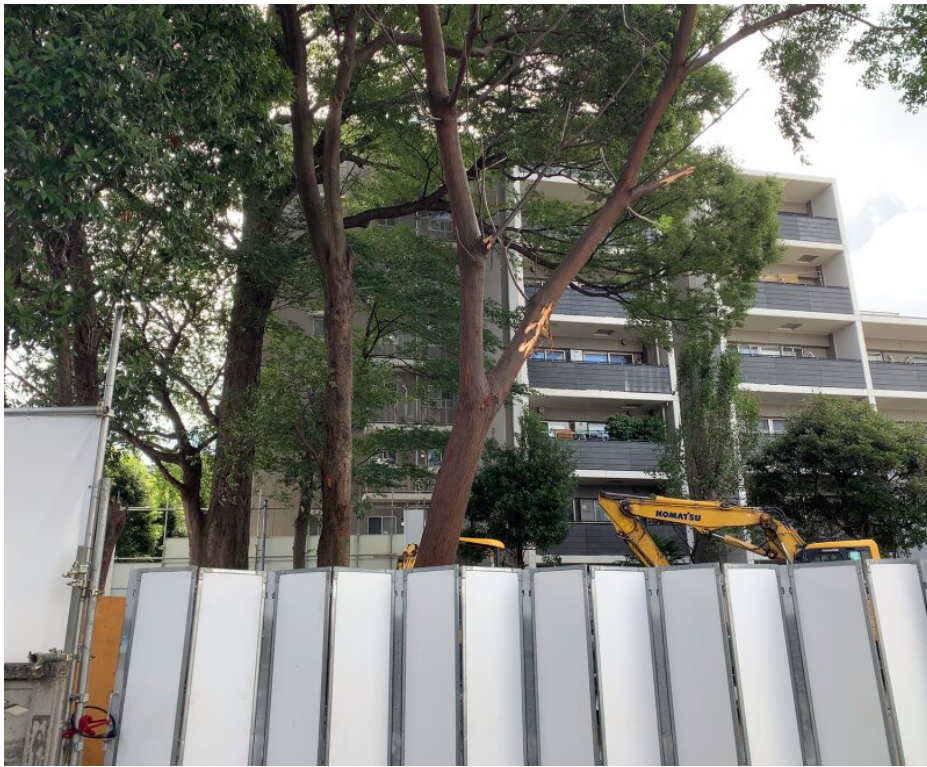
大ケヤキが立つ敷地では、7月から建物の解体工事が進められてきた（撮影・亀松太郎）
