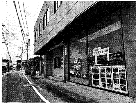
九州防衛局佐賀現地事務所
