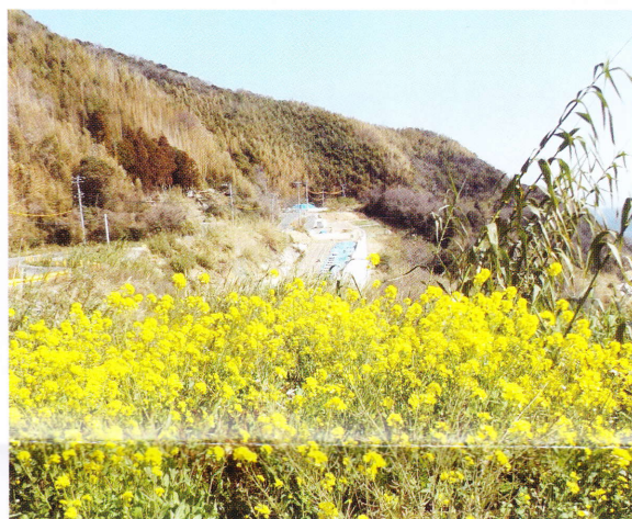
▲ 写真 町道拡幅工事
