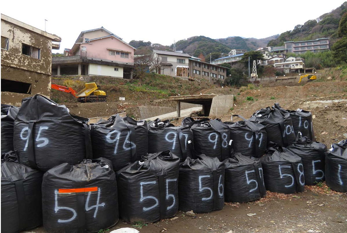
熱海市の災害復旧工事現場。土を入れた黒色のフレコンバッグが並ぶ 杉本裕明氏撮影 転載禁止
