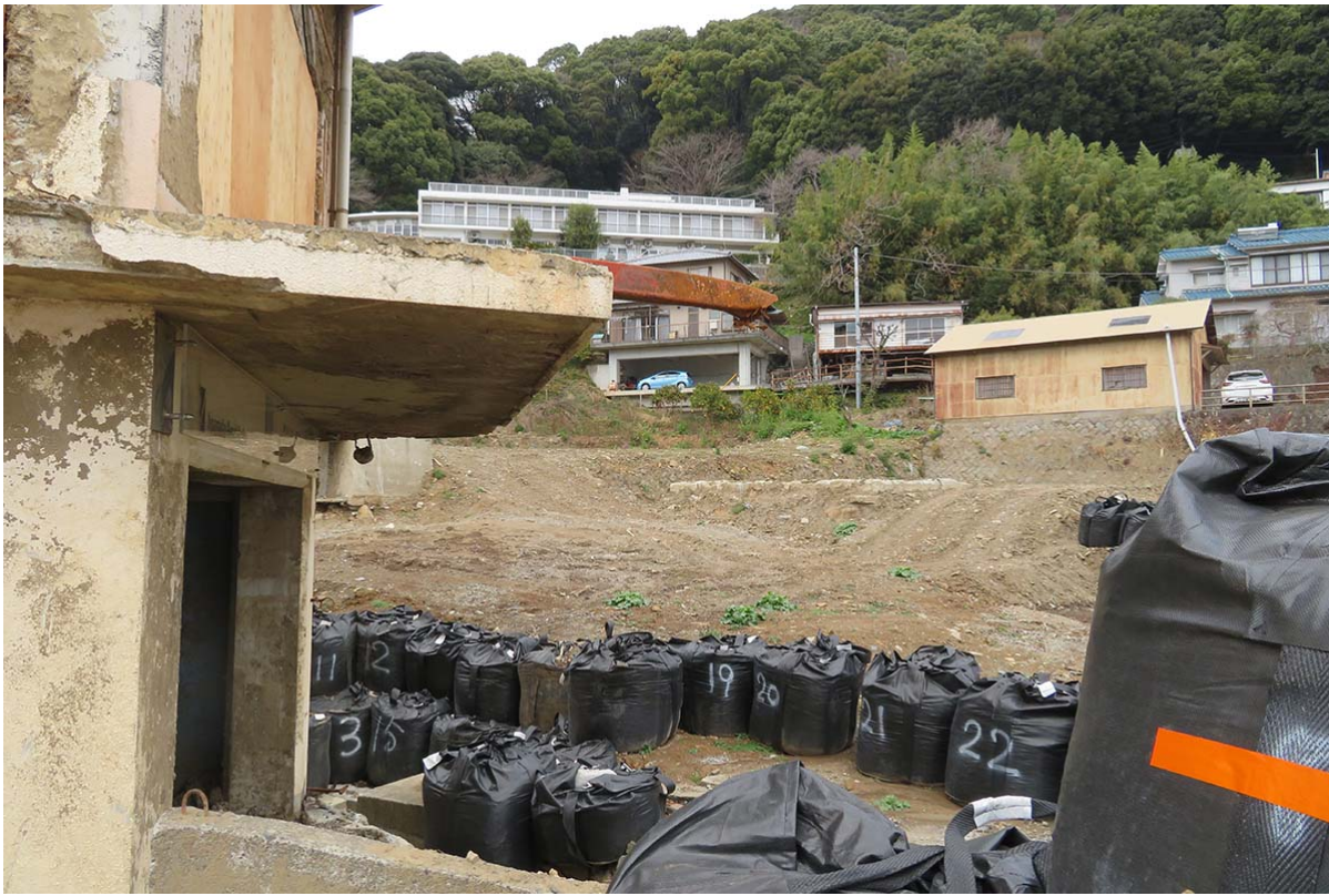
熱海市の災害復旧工事現場。土石流は左から右に一気に下った 杉本裕明氏撮影 転載禁止
