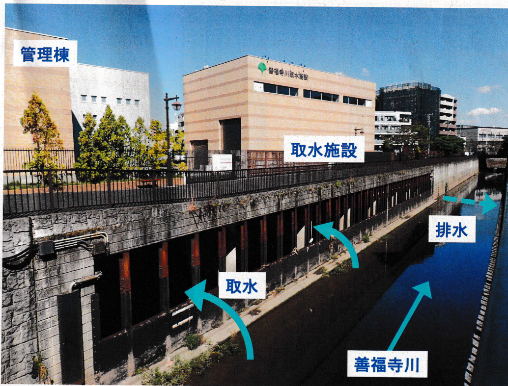
環状七号線地下調節池（善福寺川取水施設） 25
