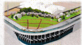
①城北中央公園調節池(一期) 都立城北中央公園(練馬区・板橋区) 規模：約250,000m 3
