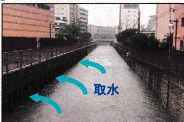
河川水位が上昇した際に取水
