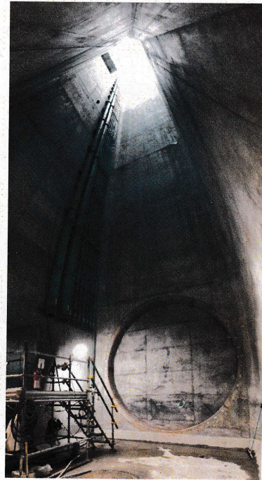
環状七号線地下広域調節池【現在施工中】 立坑状況（立坑下から上方向を撮影）
